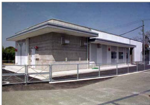
衝撃先端技術研究センターの外観
