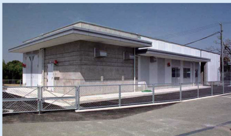
衝撃先端技術研究センターの外観
